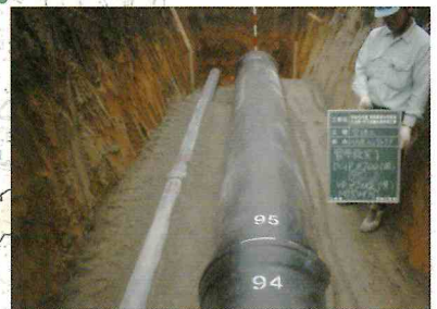
国営及び県営のパイプライン埋設工事
