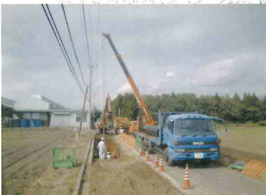
持田支線水路のパイプライン埋設工事
