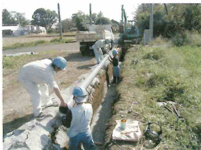
パイプライン埋設状況(平成17年度施工路線)
