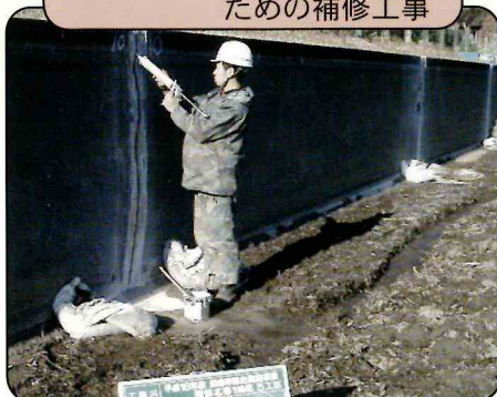
既存調整池の漏水防止のための補修工事
