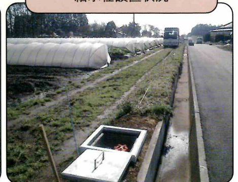
給水栓設置状況
