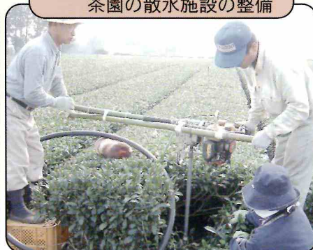
農家直営施工による茶園の散水施設の整備
