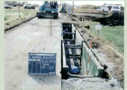
甘付付近のパイプライン工事
