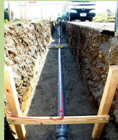
パイプラインの敷設状況
