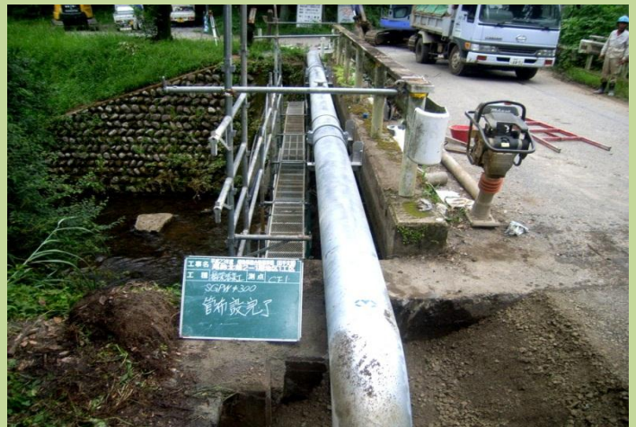
パイプラインの橋梁添架
