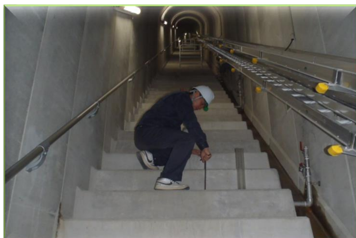
ダム監査廊の点検
