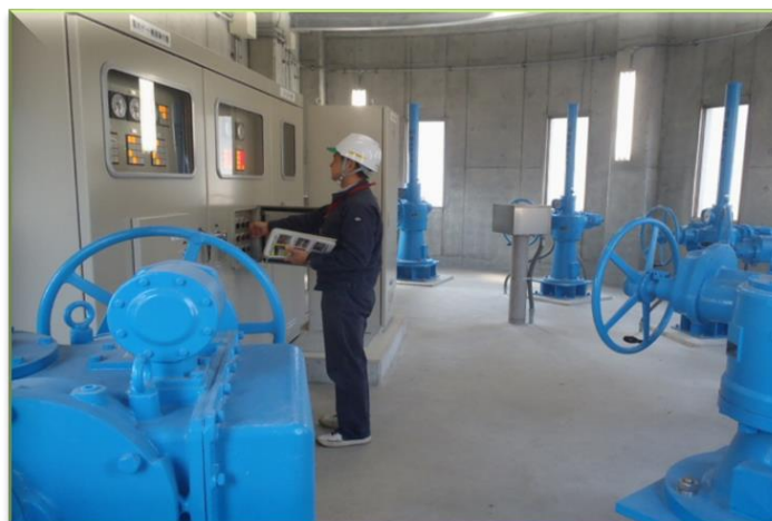
取水施設の点検
