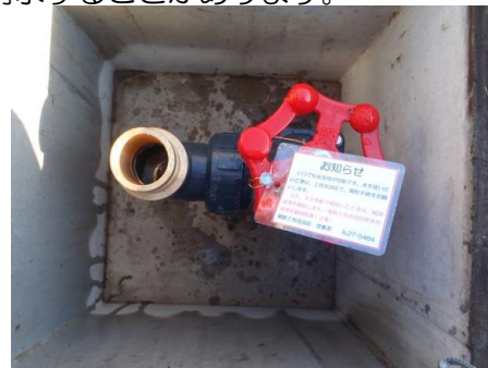
【写真3】給水栓設置工事後の状況
