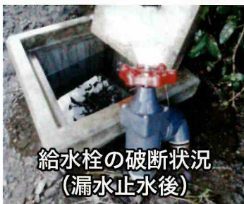
給水栓保護ボックスへの接触による漏水(①)
